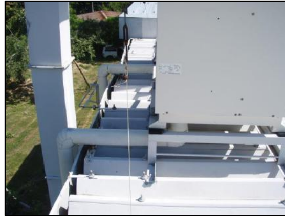
設置前室外機
