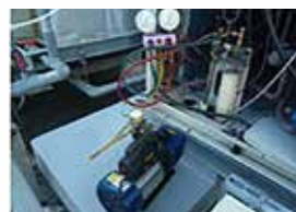
真空引き、冷媒再充填、試運転
