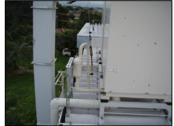
設置後室外機
