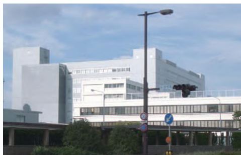
トヨタ自動車株式会社 本社工場 EPT棟
